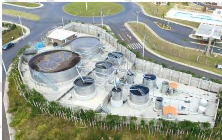
**Figura 7.1 – Vista Aérea de uma ETE pré-fabricada**
