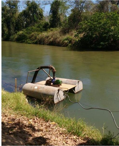
**Foto 6.1 - Captação com Balsa Flutuante – Combinado/TO**
