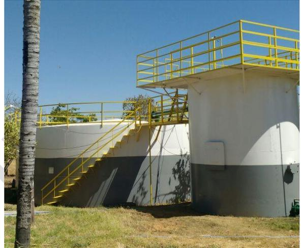
**Foto 6.3 - Vista Filtro e do Tanque de Contato da ETA em Combinado**
